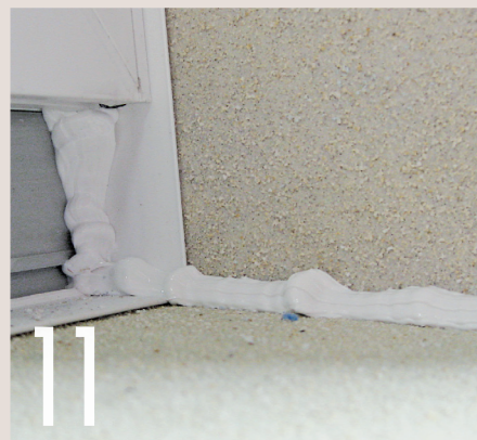
11 Alle Fugen zwischen Laibungs- und Keilplatten werden noch ausgeschäumt, bevor das Fensterbankdichtsystem zum Einsatz kommt.
