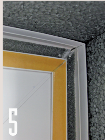
5 Das Dichtband befindet sich in der Tiefe des Fensteranschlussprofils. Es läuft rund ums Fenster und sorgt ...
