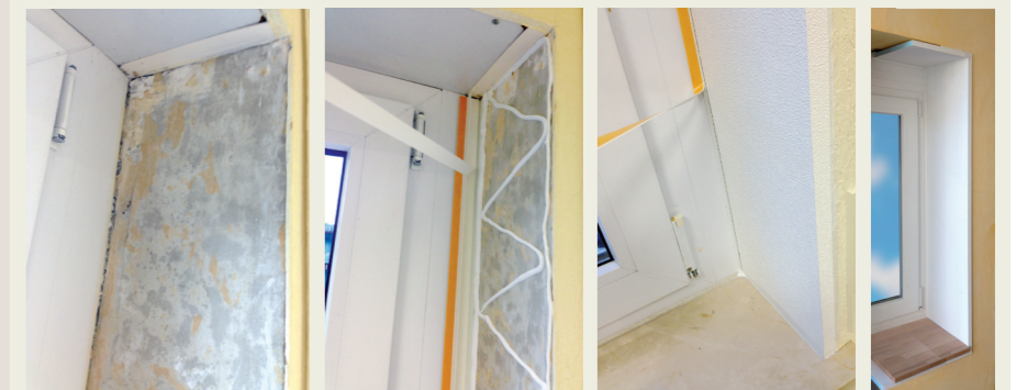
14 Und erst nach dem Verputzen von Fassade und Laibung wird die Fensterbank (Alu, Holz oder Stein) einfach aufgeschoben und hinten fixiert.
