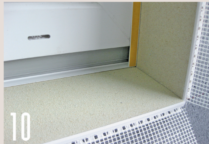
10 Zuvor wird im Fensterbankbereich eine Keilplatte eingebaut. Diese bringt schon ein gewisses Gefälle mit – weg vom Fenster zwecks Regenwasserabführung über den später aufgesetzten Sims.
