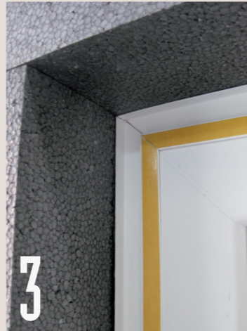
3 So sieht schließlich der perfekte Anschluss zwischen Dämmung und Vario-Fensteranschlussprofil aus.
