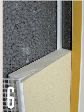
6 ... beim Einstecken der systemzugehörigen Vario-Laibungsplatte für deren lückenlos-dichten Anschluss.
