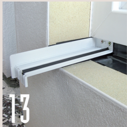
13 Der sogenannte Rillengleitabschluss wird rechts und links aufgelegt und hinten am Profil verschraubt.
