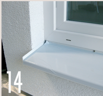
14 Und erst nach dem Verputzen von Fassade und Laibung wird die Fensterbank (Alu, Holz oder Stein) einfach aufgeschoben und hinten fixiert.
