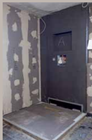
7. Es wird auf das Duschboden-Gefälleelement gesetzt und in gleicher Weise wie die Platten verklebt.
