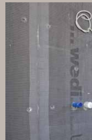
11. Die Plattenstöße werden mit einem Armierungsgewebe überdeckt und dann überspachtelt.
