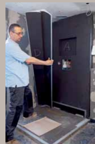
9. Auch das werkseitig vorgefertigte Eckelement wird einfach eingefügt und seitlich angearbeitet.
