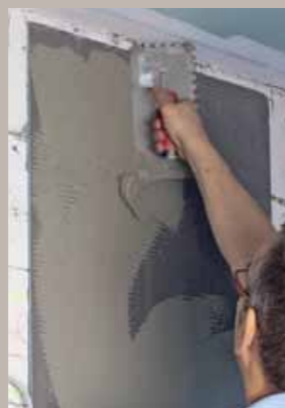
2. Zusätzlich werden auch jeweils die Rückseiten der Bauplatten dünn mit Mörtel vorgezogen.
