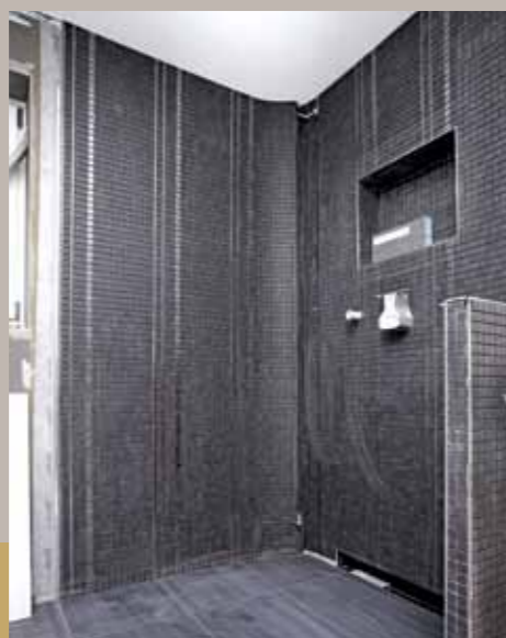
22. Fertig: Die Mosaikfliesen wurden sauber an alle Übergänge herangeführt und schmiegen sich wie eine zweite Haut über die Radien des Eckelements.
