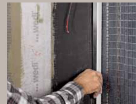
14. Die LED-Schiene wird in den Kanal des Eckelements eingebracht und mit einem speziellen Kleb- und Dichtstoff fixiert und eingedichtet.
