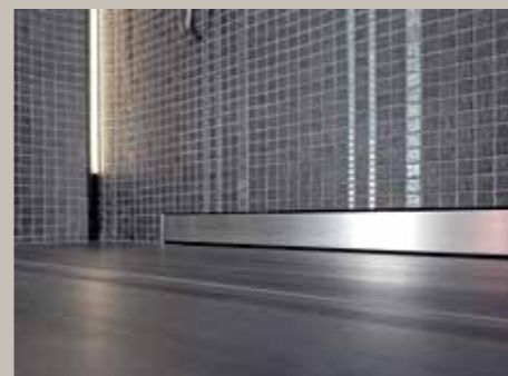
24. Eine Edelstahlabdeckung verdeckt elegant den Wandablauf. Zur Reinigung der Ablaufrinne kann sie einfach leicht abgenommen werden.
