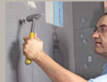
5. Da die Wand nur teilweise tragfähig war, kamen spezielle Metalldübel zur Fixierung zum Einsatz. Fünf Dübel pro Quadratmeter.
