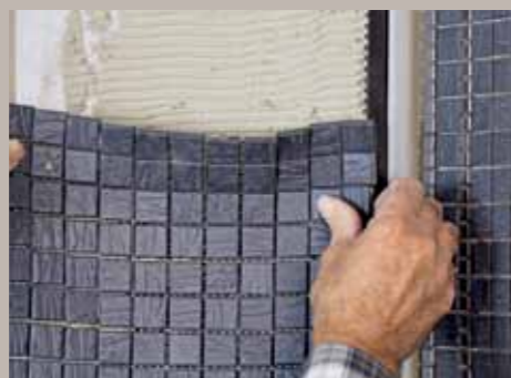
16. Da die Mosaikfliesen auf einzelnen Tafeln zusammengefasst sind, lassen sie sich gut verlegen.
