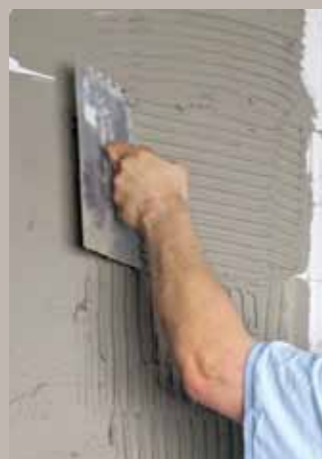
1. Zur Verklebung der Bauplatten wird Dünnbettmörtel auf die massive Rohbauwand aufgekämmt.
