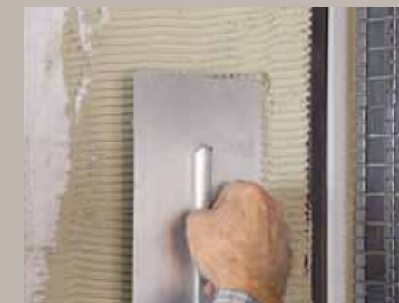
15. Die Verfliesung kann direkt auf den ebenen Bauplatten erfolgen. Dazu wird dann ein flexibler Fliesenkleber flächig aufgekämmt.
