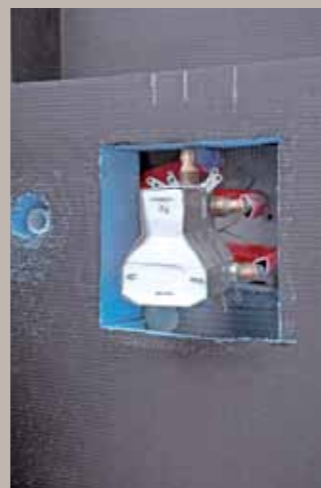
8. Wasserleitung wie UP-Armatur waren bereits montiert. Sie passen jetzt exakt in die Aussparungen.
