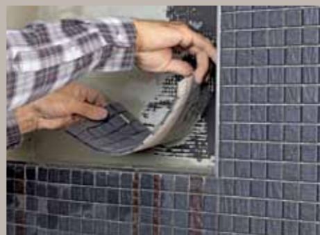
19. Anschließend wird der Boden mit entsprechend zugeschnittenen Mosaiktafeln ausgelegt.
