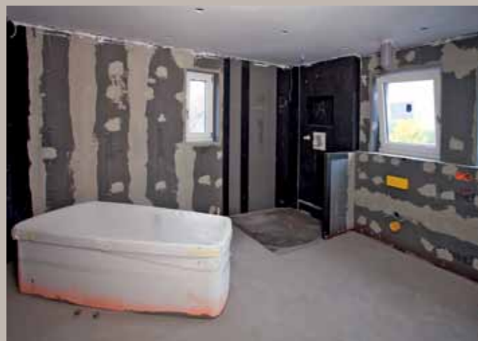
12. Auf diese Weise entstand die Eckdusche samt „Schamwand“ zum WC. Der gesamte Raum wurde mit Bauplatte ausgekleidet und bekam so ebene Wände, die erforderlichen Installationswände und eine Wärmedämmung.
