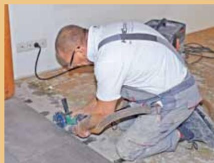
15. Nach einer gewissen Teilfläche wurde der Estrich entlang der Fliesenkante aufgefräst, ...
