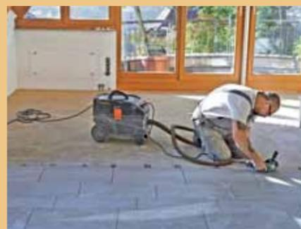
16. ... um quer im Raum eine Dehnfuge anlegen zu können. Diese wird dann elastisch verfugt.
