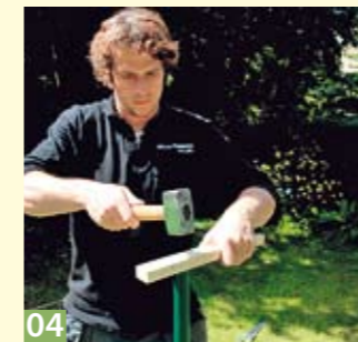
03 ... etwas eindrücken, mit einer Winkelwasserwaage ausrichten. Dann werden die Hülsen bündig in den Boden eingeschlagen.
