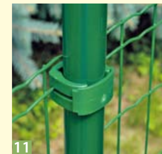
07 Mit der Befestigung des Gitterzauns mit Clips wird am Endpfosten begonnen. Dann rollt man den Zaun erst einmal ab.
