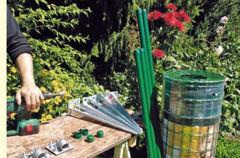
03 ... etwas eindrücken, mit einer Winkelwasserwaage ausrichten. Dann werden die Hülsen bündig in den Boden eingeschlagen.
