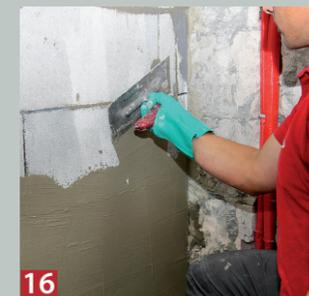
**16** Bei nachfolgendem Auftrag einer Verbundabdichtung – wie im Nassbereich erforderlich – wird die Fläche noch abgespachtelt.
