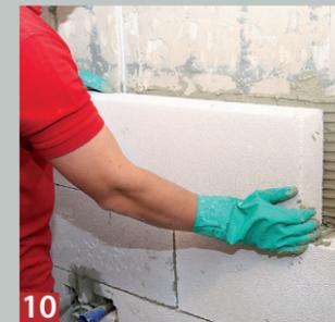
**10** Um ungewollte Brüche zu vermeiden versetzt man die Porenbetonsteine im Verband, das heißt kreuzfugenfrei.
