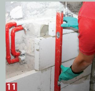
**11** Auch während des weiteren Aufmauerns die Steine in der Lot- und Waagerechten regelmäßig mit der Wasserwaage überprüfen.
