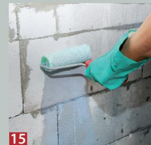
**15** Für nachfolgende Arbeiten werden die stark saugfähigen Porenbetonsteine mit einer Grundierung vorbehandelt.
