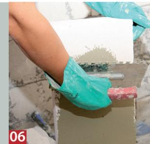
**06** Auf die entstaubte Rückseite des Porenbetonsteins wird eine vollflächige Kontaktschicht aus dem Kleber glatt aufgezogen.
