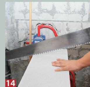
**14** Mit einer geeigneten Säge – es genügt schon ein starrer Fuchschwanz – werden die erforderlichen Zuschnitte angefertigt.
