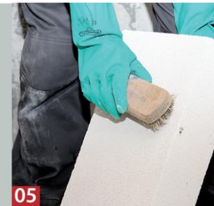
**05** Staub und lose Teilchen behindern den erforderlichen Kontakt zum Kleber. Sie werden weggebürstet oder abgesaugt.
