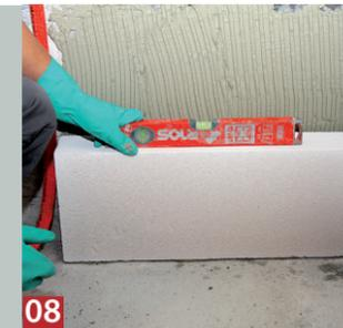
**08** Mit Hilfe einer Wasserwaage wird nun überprüft, ob er waagrecht und lotrecht richtig sitzt. Notfalls wird noch korrigiert.
