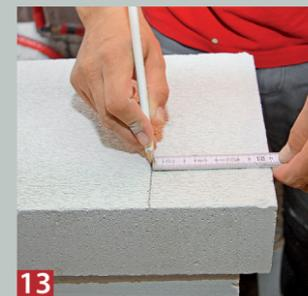
**13** Die Maße für Abschnitte oder auch Ausklinkungen werden genau auf einen Porenbetonstein oder ein Reststück übertragen.
