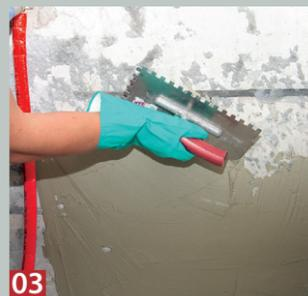
**03** Zunächst muss eine Kontaktschicht hergestellt werden. Man zieht den Kleber mit der glatten Seite der Kelle unter Druck auf ...
