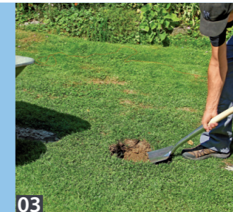
03 Die Fundamentlöcher werden mit 40 cm Seitenlänge und 80 cm Tiefe – der Frostgrenze wegen – ausgehoben.
