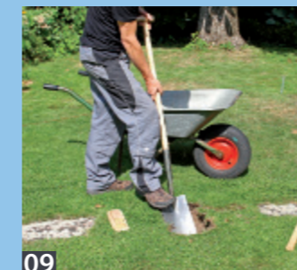
09 ... den nächsten Pfosten anhalten, Stellen für die Zaunfelderhalter markieren und ein weiteres Fundament anlegen.
