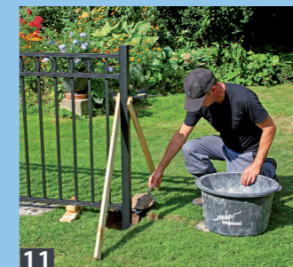
11 ... und wird anschließend einbetoniert. Dann die weiteren Zaunfelder in dieser Weise montieren, bis der Zaun fertiggestellt ist.
