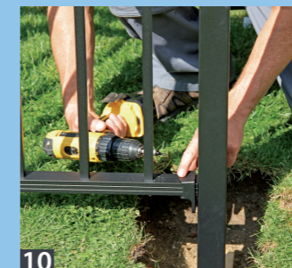
10 Das Zaunfeld ausrichten, mit Keilen sichern und am Pfosten befestigen. Der Pfosten muss ebenfalls auf Kies aufstehen ...
