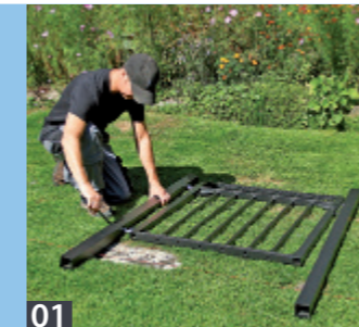
01 Erst wird der Klobenpfosten mit dem Tor verbunden. Die Kloben von unten und oben in die Rollen einhängen und die ...
