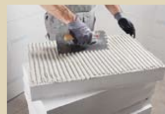
2. Dann den Klebspachtel vollflächig auftragen und mit einer Zahntraufel durchkämmen.
