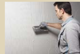
8. Nach der Grundierung den Flächenspachtel auftragen und mit der Zahntraufel durchkämmen.
