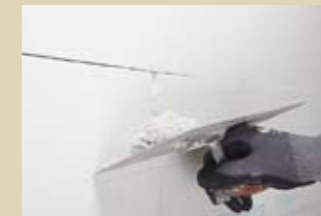
6. Eventuelle Fugen, die größer sind als 2 mm, schließt man mit dem dazugehörigen Füllmörtel.
