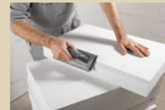
5. Die robuste, in sich stabile Platte kann bei Bedarf auch leicht angeschrägt und verjüngt werden.
