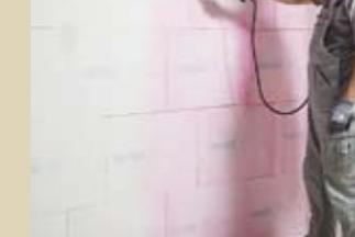
7. Die Grundierung dient zur Verbesserung der Haftfähigkeit der Oberflächenbeschichtung.
