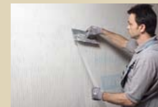
9. Das Gewebe vollflächig in den Spachtel einbetten, in Stoßbereichen 10 cm überlappend.
