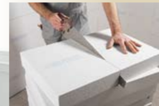
4. Passstücke lassen sich am besten mit einem feinzahnigen Fuchsschwanz auf Maß zuschneiden.
