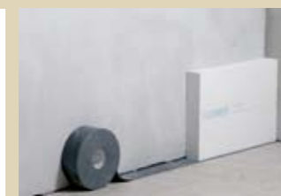
1. Vor der Verklebung wird ein Entkopplungsstreifen auf dem Fußboden aufgebracht.
