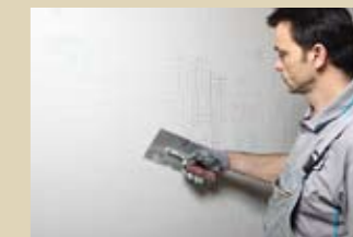
10. Das Gewebe muss im oberen Drittel der Armierungsschicht liegen, insgesamt 4 bis 5 mm dick.
